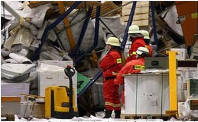
Lagerhalle des Papiergroßhändlers Igepa in Queis bei Halle: Fünf Menschen sind hier unter einem eingestürzten Hochregal verschüttet worden, zwei starben. (Foto: dpa)
