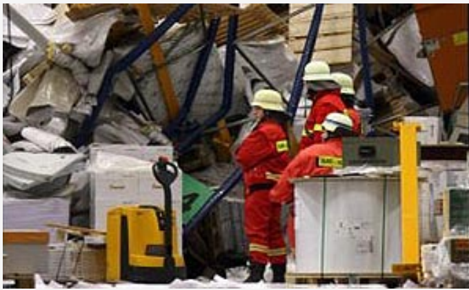
Lagerhalle des Papiergroßhändlers Igepa in Queis bei Halle: Fünf Menschen sind hier unter einem eingestürzten Hochregal verschüttet worden, zwei starben. (Foto: dpa)
