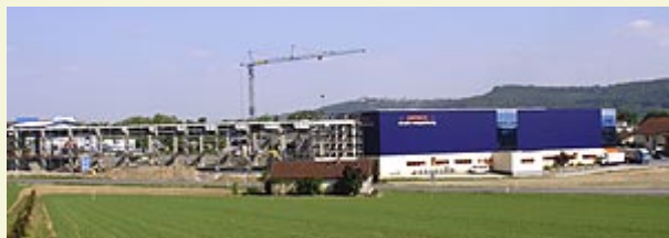
Nach seiner Fertigstellung im September 2006 bietet das Hepack-Lager Platz für ca. 2700 Europaletten. (Foto: Horstmann)
